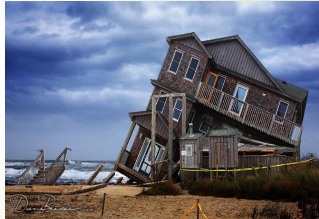
Gevolg van ontbrekend fundament
